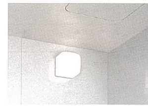
■フラット天井&照明(2灯) 照明は、60W白熱球。 カバーは割れにくい樹脂製です。
