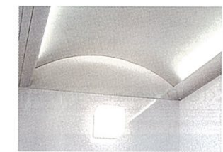
■ドーム天井&照明(壁付+間接) 間接40W蛍光灯2灯 壁付照明はフラット天井と同じになります。
