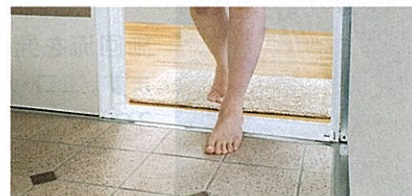
3 段差を抑えた出入口
