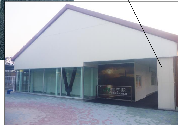
施工箇所 全景
