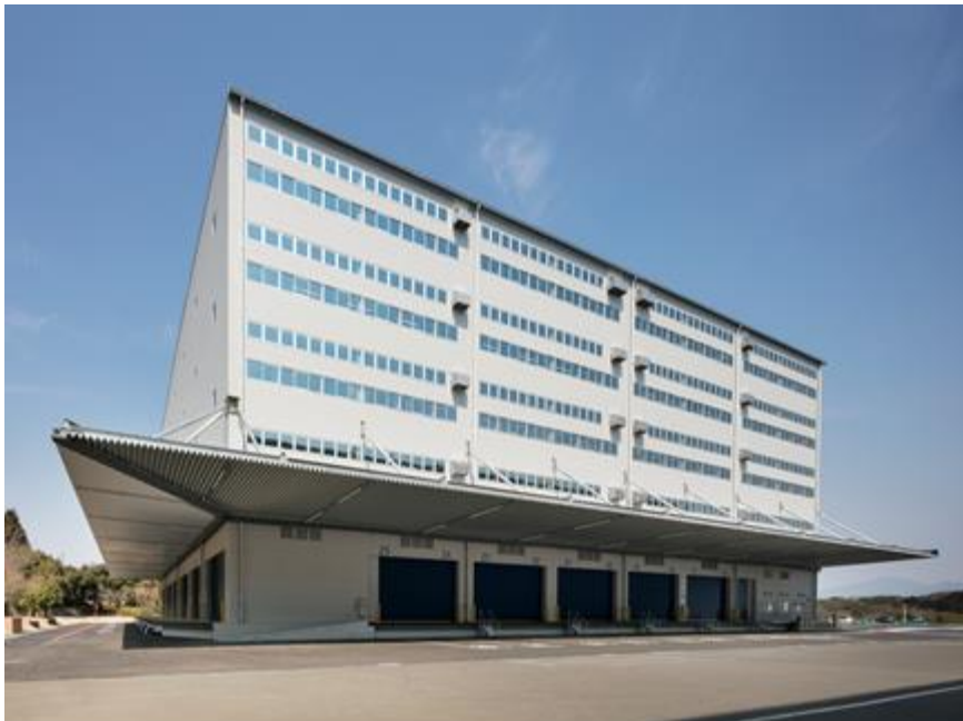
福岡物流センター 外観
