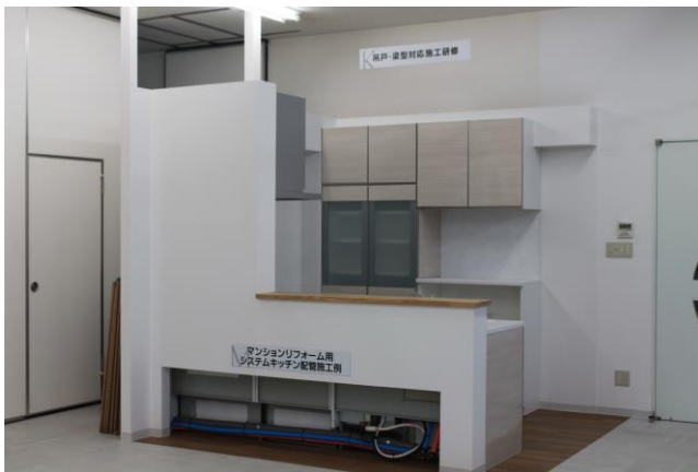
（システムキッチンの配管施行例）
