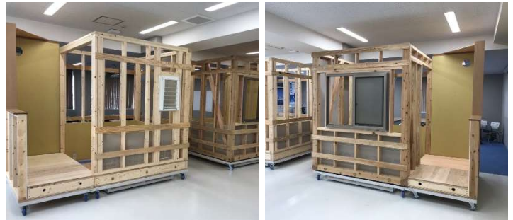
(システムバス実習什器／左：2×4 工法仕様、右：在来工法仕様)
