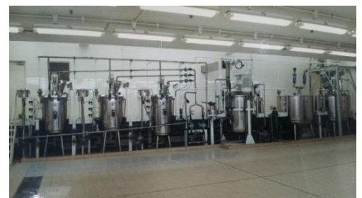
（アクリル樹脂の原料タンク）
