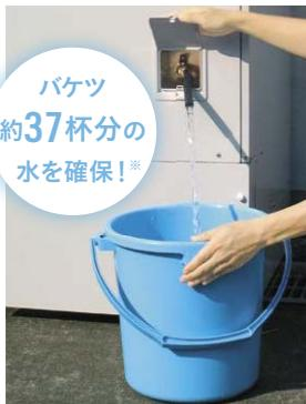
※タンク容量460Lフルオート電気温水器(利用可能量365L)、バケツ1杯10Lで換算。利用できる水の量は機種により異なります。
