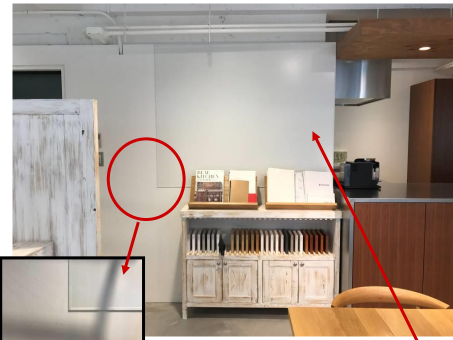
端部は樹脂製のサイドモール仕上げ
