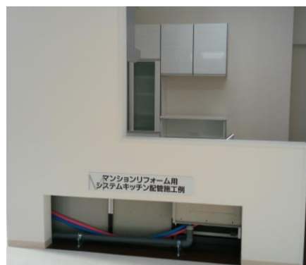
システムキッチンの配管施工例
