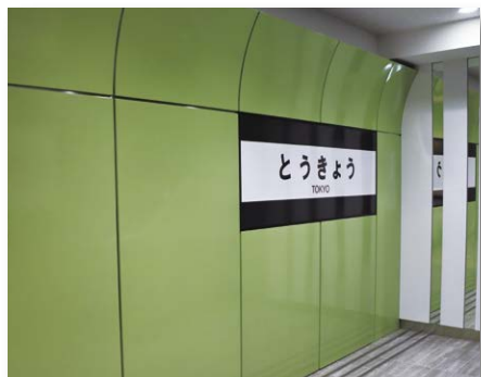
■鉄道コンコース ホーローと他素材を組み合わせ、グリーンを基調とした、和を感じさせる駅構内。
