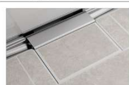
タイル仕上げ
