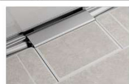
タイル仕上げ
